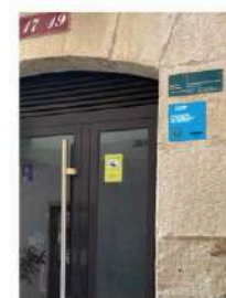
Placa / etiqueta del edificio evaluado con código QR que lleva el informe completo
