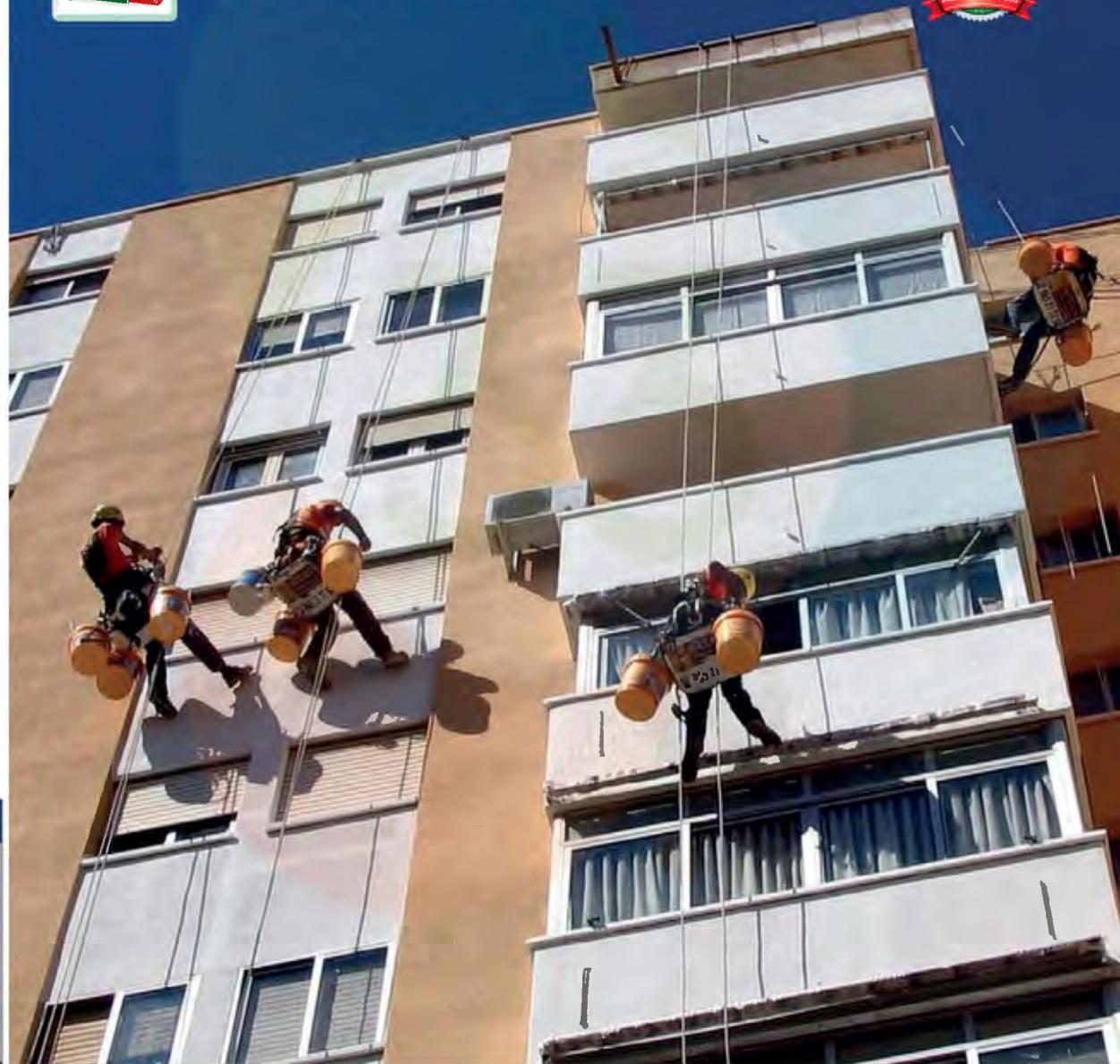
*GAINA es un aislante térmico ecológico tanto exterior como interior elaborado a partir de una solución de cerámica líquida que al solidificar le confiere unas excepcionales propiedades aislantes, siendo 100% ignífugo y logrando un ahorro energético de hasta un 40% en calefacción y aire acondicionado.*
